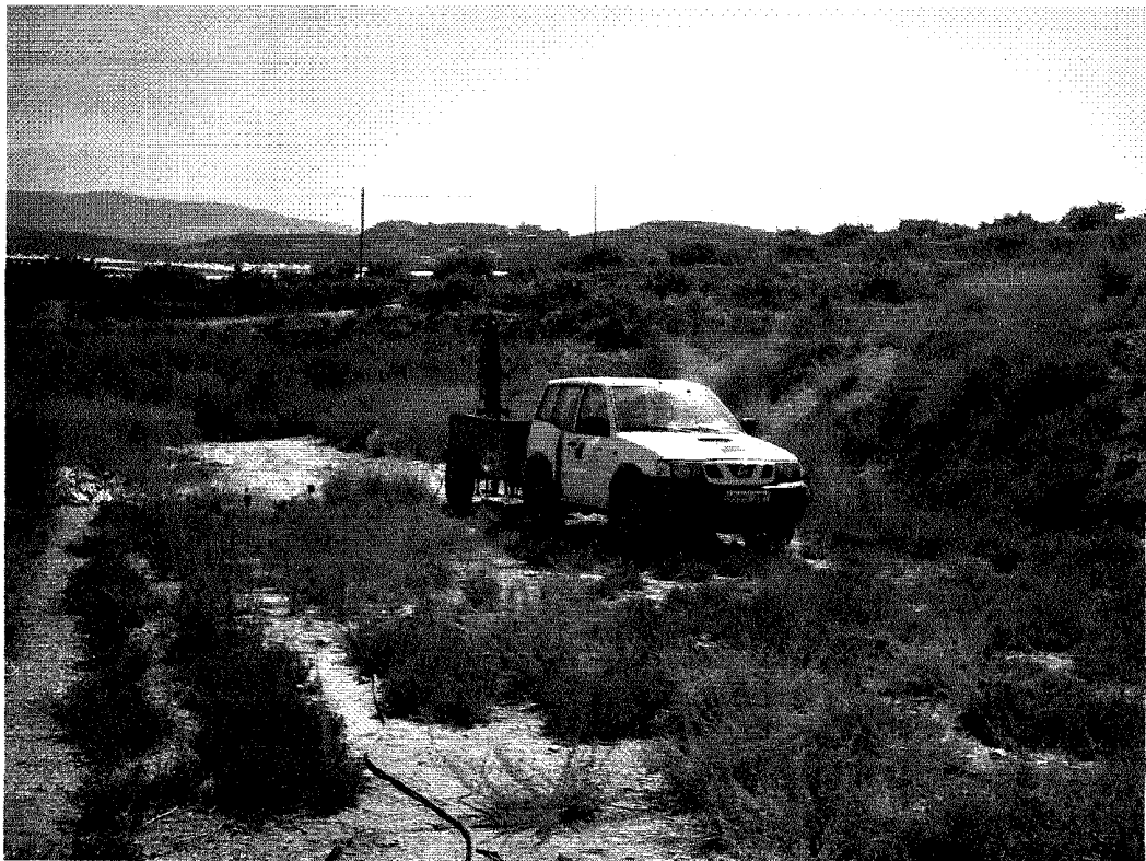
Varias vistas del solar con penetrómetro realizando ensayos
