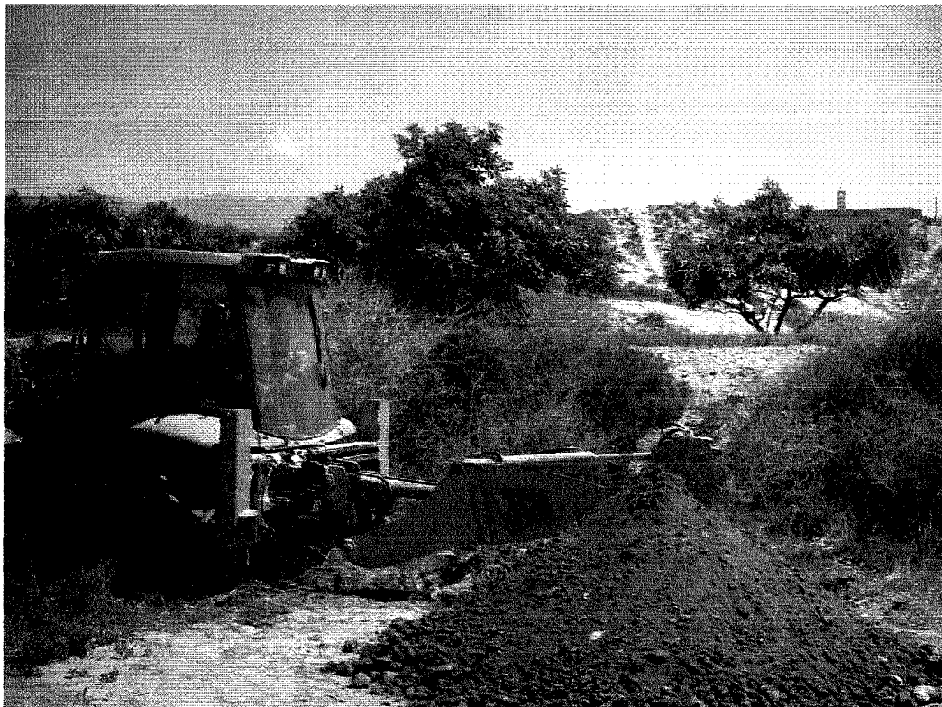
Otras vistas de la parcela con retroexcavadora realizando calicatas
