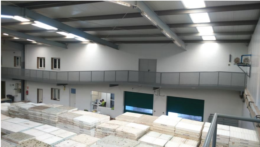
Vista general planta primera oficinas y entreplanta nave.
