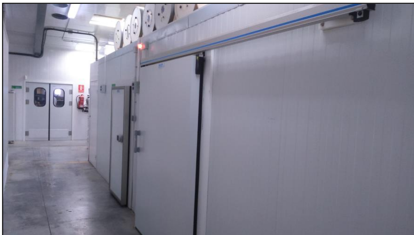
Nave entreplanta-Laboratorio .-Cámaras
