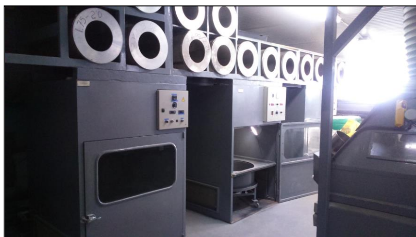
Nave entreplanta-Laboratorio .-Zona de secado
