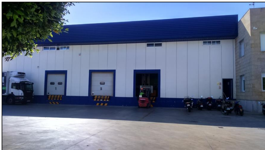
Nave zona muelles
