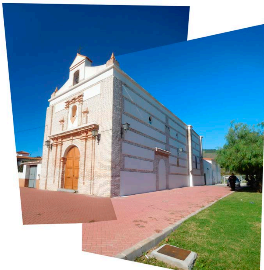
Imagen exterior actual de la Iglesia de San Antonio. Fachadas Sur y Este.
