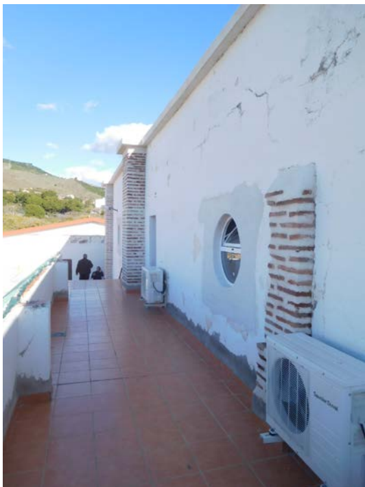
Imagen cubierta transitable de acceso a Entreplanta.
