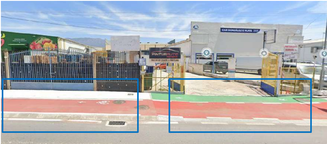
Figura 8. Estado actual de la parcela y situación de acceso existente y nuevo a ejecutar
