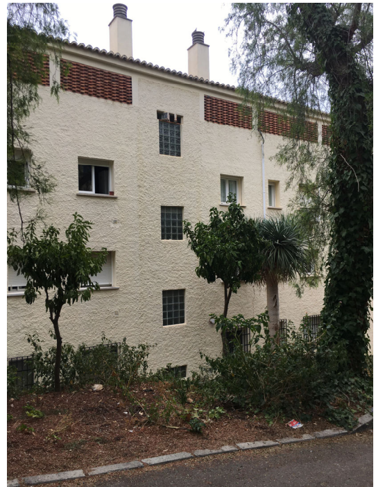
Fachada posterior a calle Capitán Jiménez
