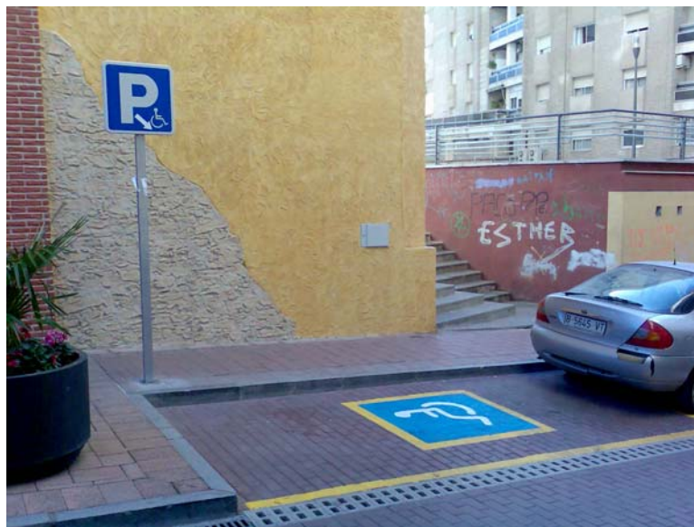
Fotografía 17 Señalización vertical y horizontal plaza adaptada
